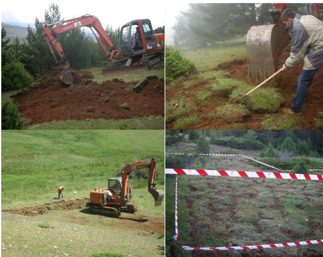
Fotos 35 a 38. Preparación de los bancales receptores, colocación de los tepes con medios mecánicos y manuales y estado final con los bancales balizados.
