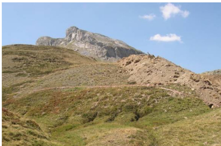
Fotos 12 y 13. Arriba: Detalle de Lycopodium clavatum ; Abajo: Balizado de protección en las inmediaciones de las obras de pistas.
