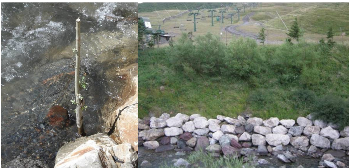
Fotos 42 y 43. Izda. Estaquilla de Sauce capruno ( Salix caprea ) brotando en una restauración en el barranco de Ardonés en Cerler; Dcha. Talud del río Gállego en Formigal recuperado con abundante presencia de salix procedente de estaquillado.
